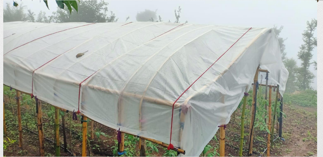
वडा नं ३ मा पालिकाद्वारा प्लास्टिक घर निर्माण
