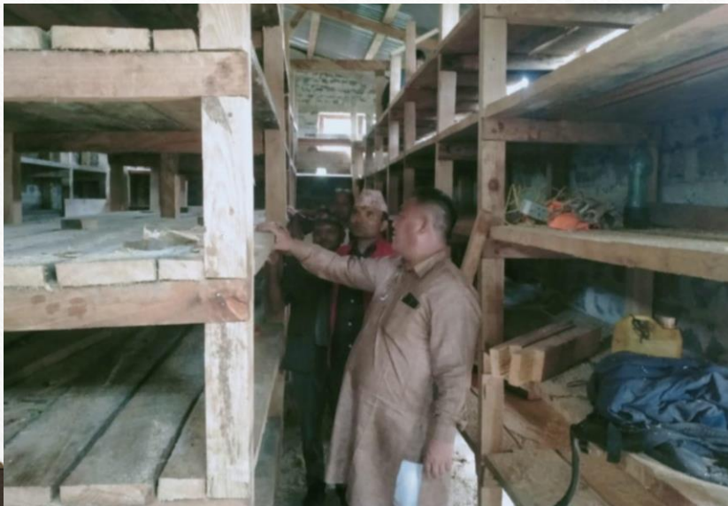
रस्टिक स्टोरको निर्माण प्रक्रियामा अनुगमन
